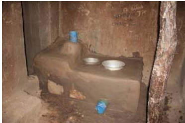
Picha Na. 16: Jiko liko tayari kwa ajili ya matumizi baada ya ujenzi wa siku saba
